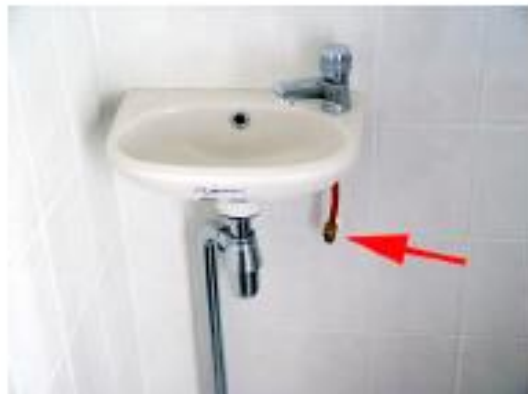
Afb. 12 Drinkwaterleiding naar een fontienkraan
