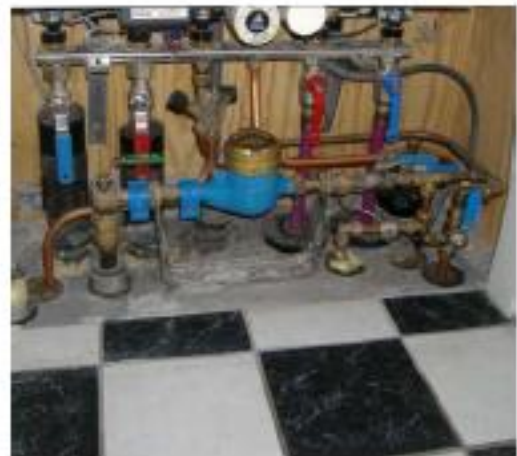
Afb. 4 Watermeteropstelling
